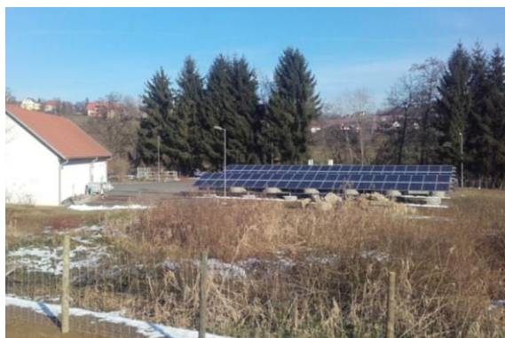
Kläranlage in Riegersburg
