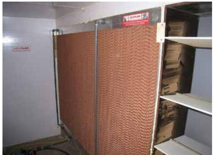
Abbildung 11: Coolpad im nachträglichen Einbau (Quelle: Zentner)
