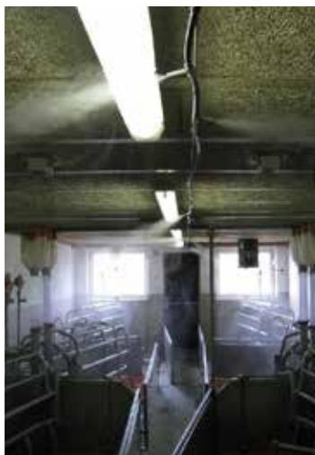
Abbildung 7: Wasser-Hochdruckvernebelung in der Abferkelung (Quelle: Zentner)
