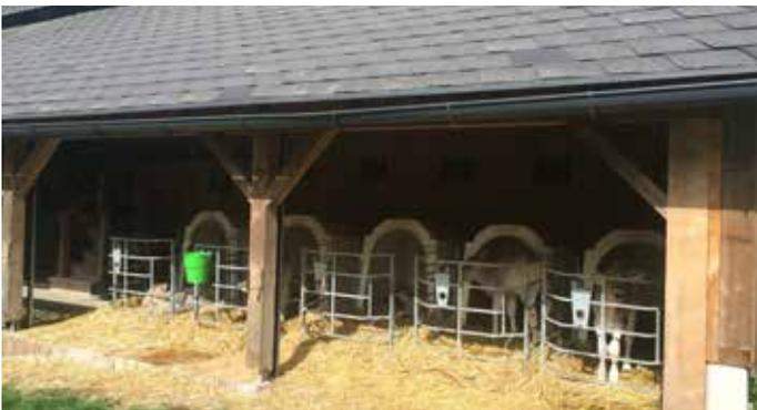
Abbildung 6: Dachüberstände reduzieren den solaren Energieeintrag erheblich (Quelle: Zentner)
