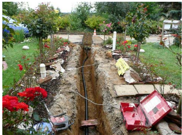
Abbildung: Grabungsarbeiten für den Hausanschluss sind auch auf sensiblen Grundstücken problemlos möglich!
