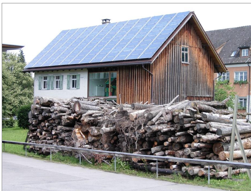
Abbildung 7: Dachintegrierte PV-Anlage (Quelle: Freiding Erneuerbare Energien GmbH)
